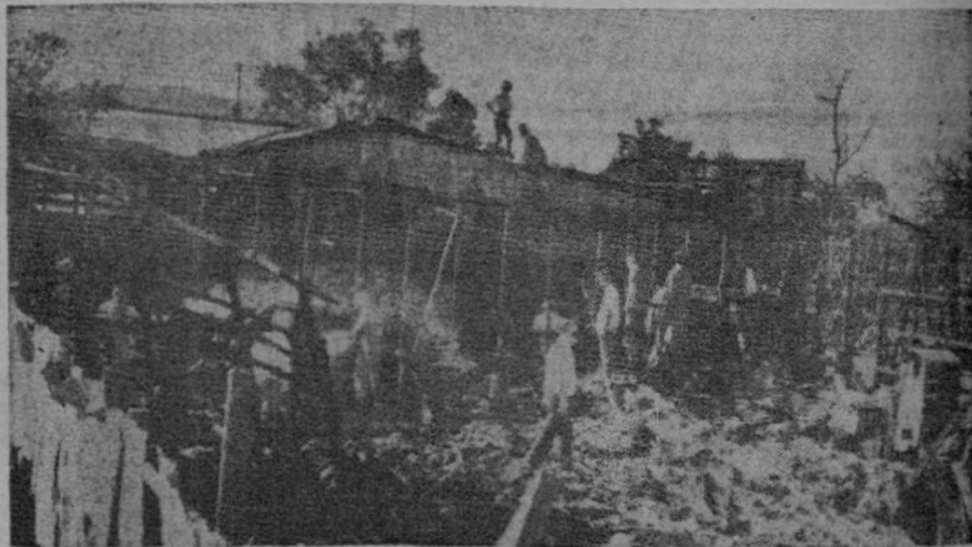
APAGANDO ESCOMBROS. — El fuego rápidamente destruyó dos propiedades y dañó otra parcialmente hoy en la mañana, a 100 metros del mercado
